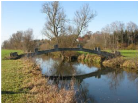
Hundsbrücke bei Günding
